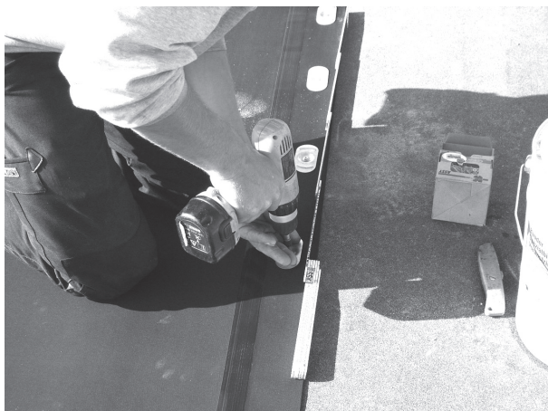
7.2 Mechanische bevestiging van een EPDM baan
