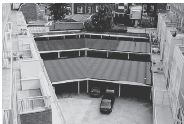
11.2 EPDM dak in aanleg
