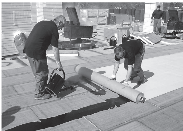
3.4 Toepassen van een scheidingslaag tussen de PVC dakbaan en de EPS isolatie
