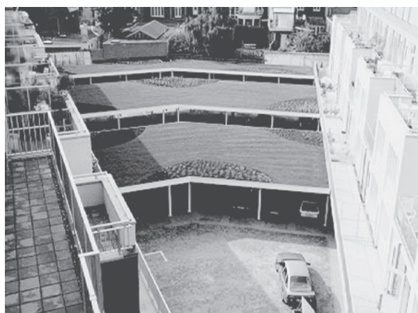
11.3 EPDM dak met afwerklaag
