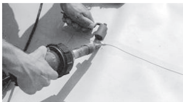
4.3 Druk is van essentieel belang voor het realiseren van een duurzame lasverbinding
