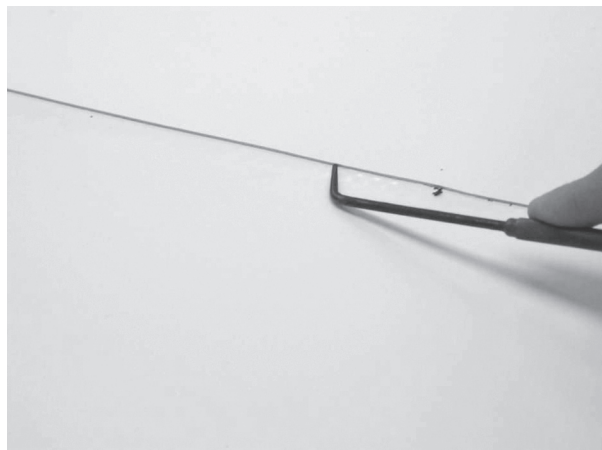
4.5 Controle van de naad met een controle-naald
