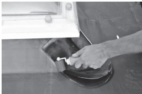
9.11 Inwerken van een lichtkoepel
