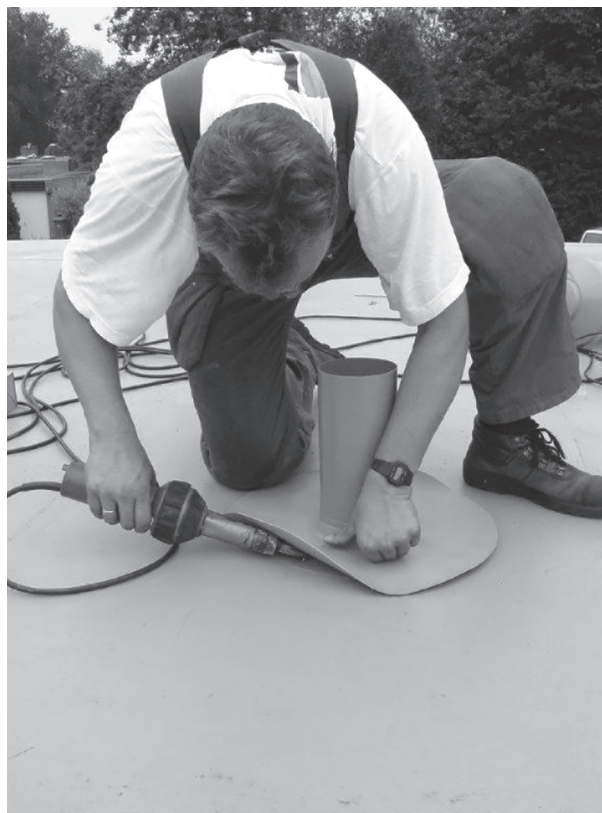
6.27 Plakstuk aansluiten op dakvlak
