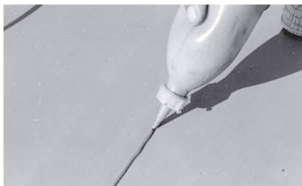
4.6 Aanbrengen van vloeibare PVC
