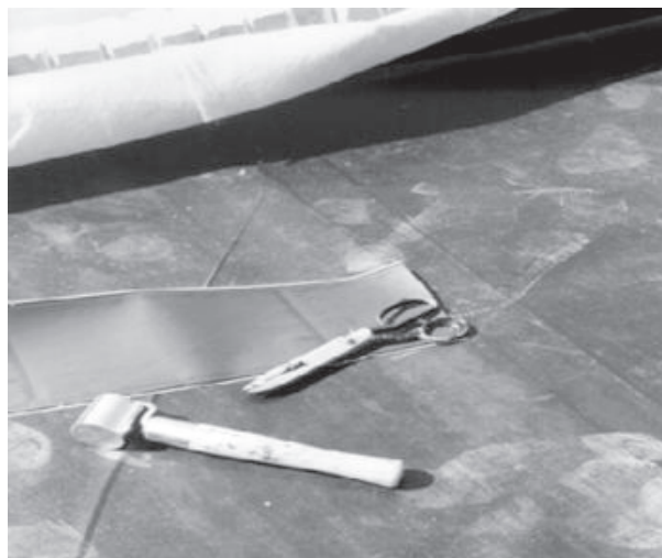
7.4 Gereedschappen voor aanbrengen van EPDM
