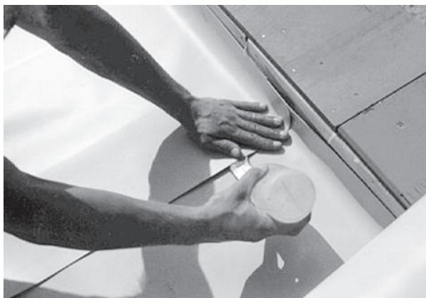
4.1 Lassen met THF lasvloeistof
