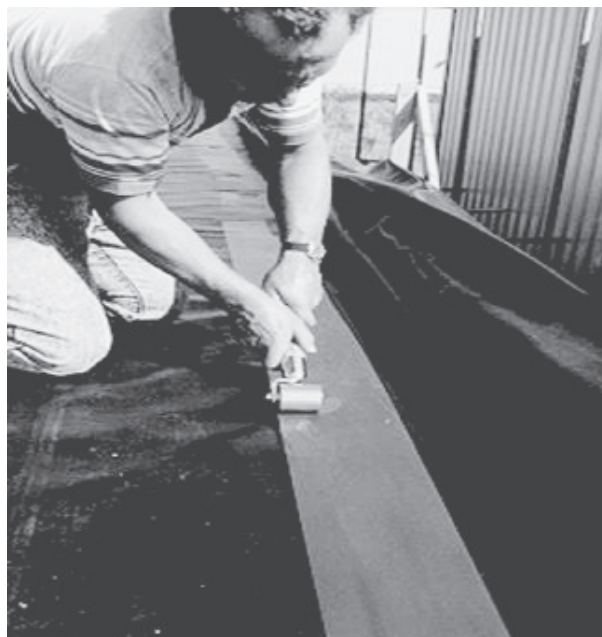
7.3 EPDM naadverbinding in het werk
